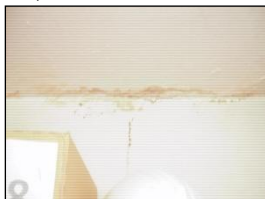
Ubicación de funcionarios en área debajo de tuberías de aguas negras las cuales gotean, falta de aireación, humedad en paredes
