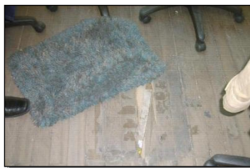
Hacinamiento, pisos en madera rotos, falta de elementos de trabajo, falta de iluminación y aireación
