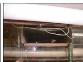
Ubicación de funcionarios en área debajo de tuberías de aguas negras las cuales gotean, falta de aireación, humedad en paredes
