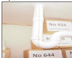
Ubicación de funcionarios en área debajo de tuberías de aguas negras las cuales gotean, falta de aireación, humedad en paredes
